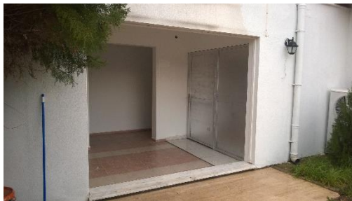
Rektörlük Araç Park Merkezi ve Morfoloji Yangın Kaçış Merdiveni Tadilatı
