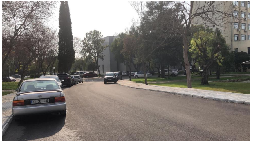
Rektörlük binası yol, yağmur suyu hattı ve çevre düzenleme çalışmaları
